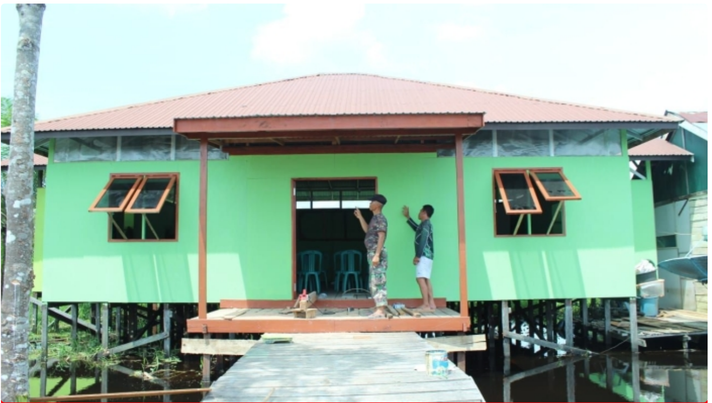
Sasaran Fisik TMMD Ke-115 Rehab Balai BPD Capai Tahap Finising
