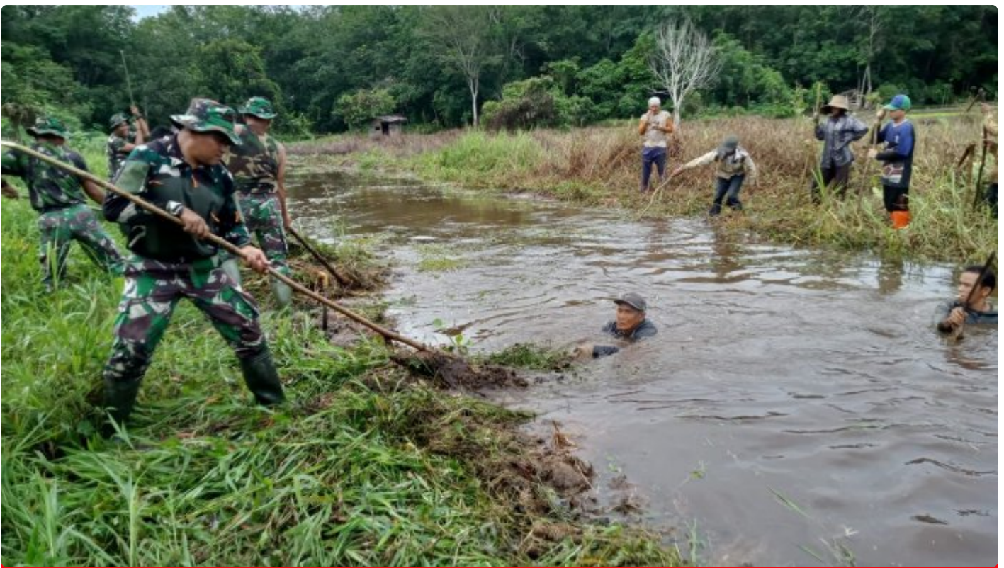
Cegah Batingsor Koramil 1001-05/Lampihong Bersihkan Saluran Air
